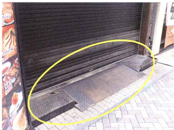
店舗前のバリアフリー用スロープ
