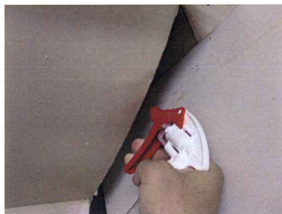
隙間よりラットアウトをスプレー
