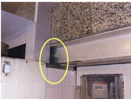
構造上隣接店舗からの進入も考えられるので 防鼠ブラシを設置
