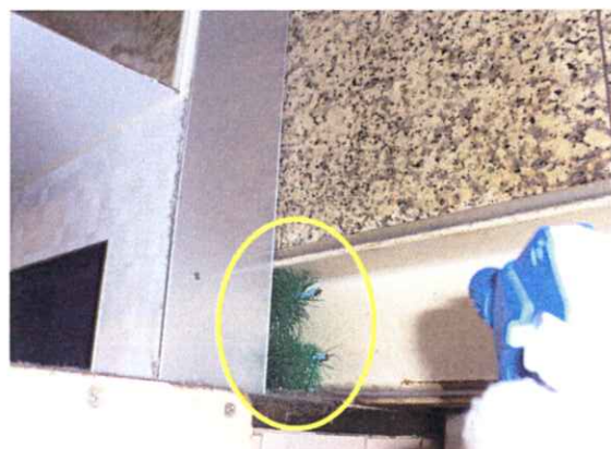
防鼠ブラシ及びラットサインの認められる 箇所にもラットアウトをスプレーする
